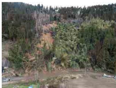
豪雨被災状況
