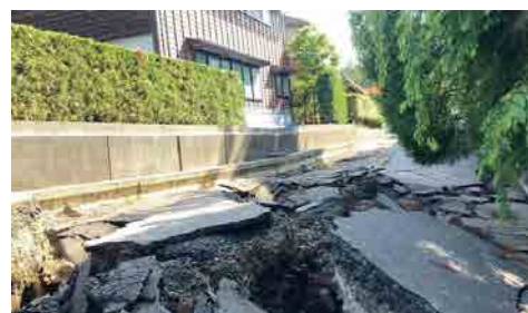
住宅地内での道路崩落が多発 生活基盤の復旧が急務であった
