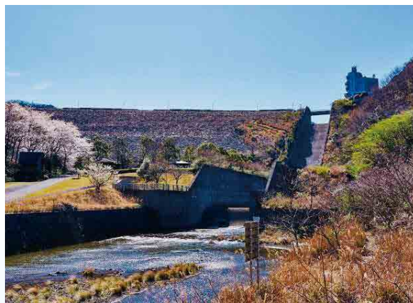
奥野ダム (提供:伊東市)
