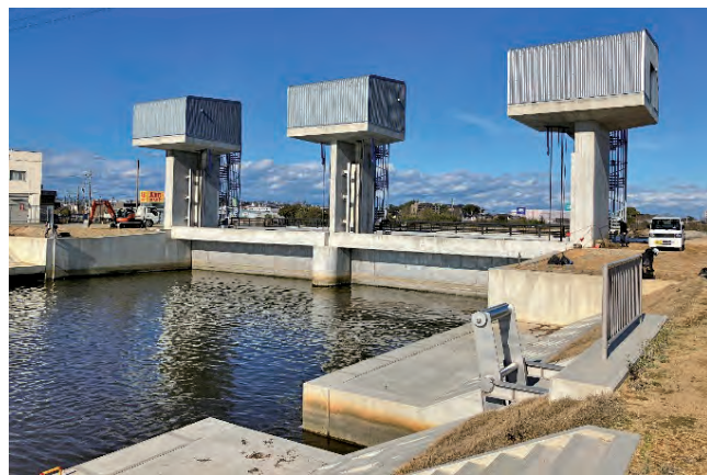
堀留川水門の完成状況
