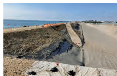
本土工（第1工区）
