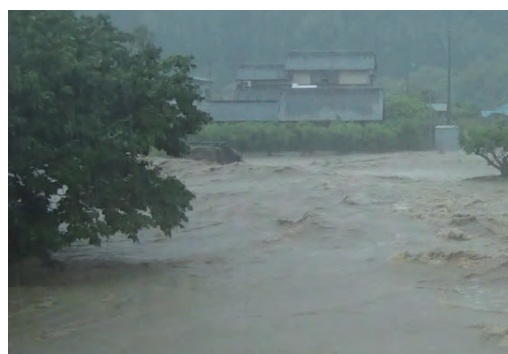
令和5年台風第2号による堤防決壊及び浸水状況
