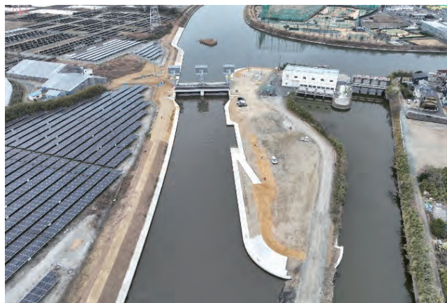
堀留川の全景
