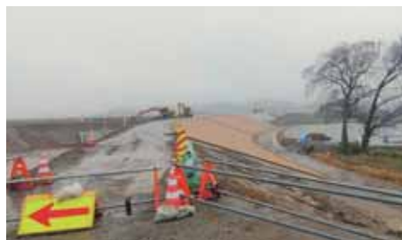
吉田川災害復旧現場（宮城県大郷町）
