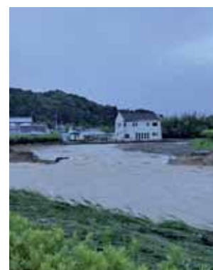
二級河川敷地川の堤防決壊 （磐田市敷地）
