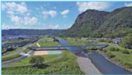
川の駅「伊豆城山」全景
