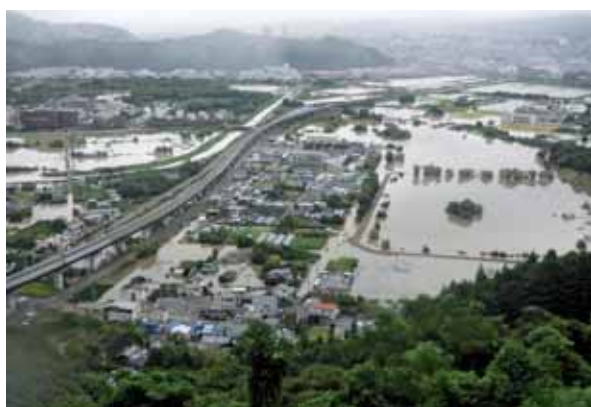
台風第15号による麻機遊水地状況
