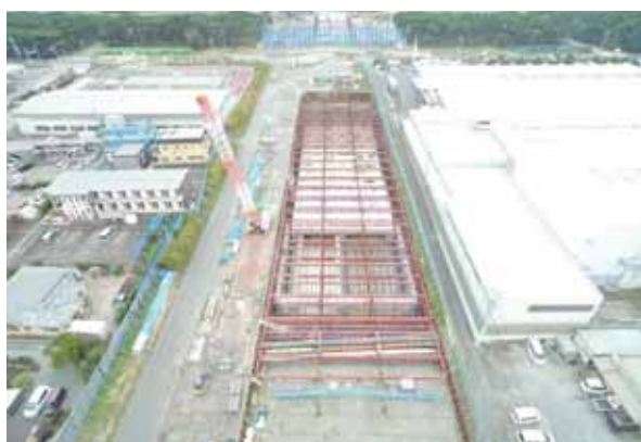
県道富士清水線北側（県施工箇所）
