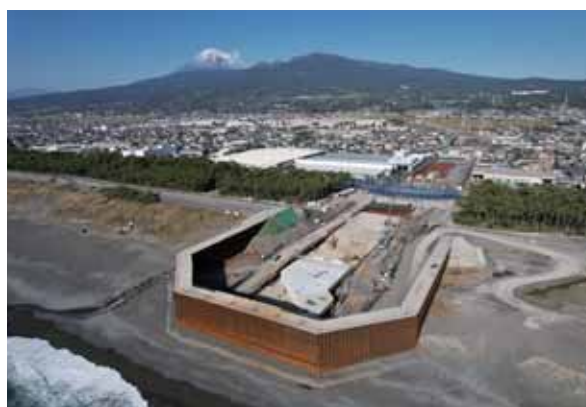
海岸防潮堤部（国土交通省施工箇所）
