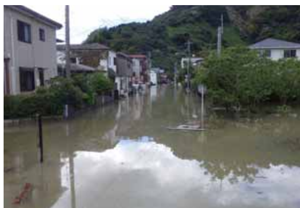
台風第15号による上流域（葵区）浸水状況
