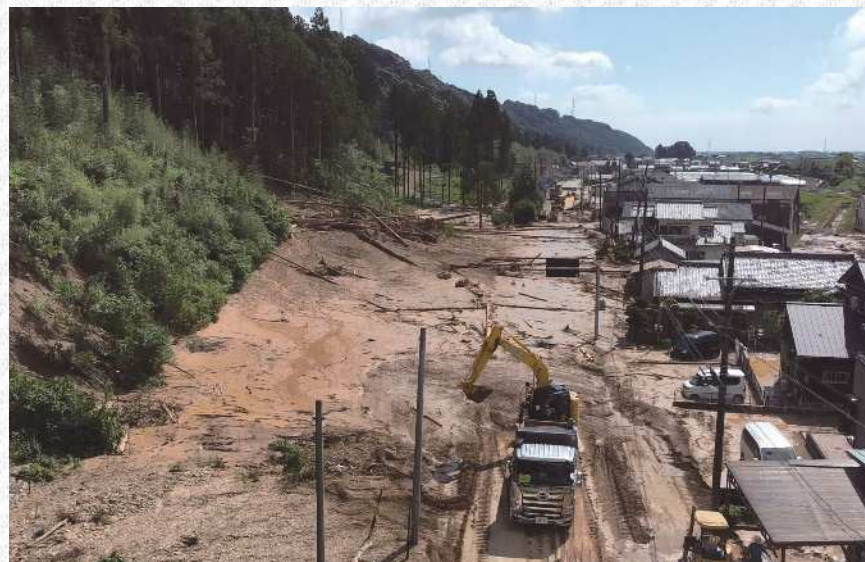
【左】(主)磐田天竜線(磐田市神増) ※台地の西側斜面から流れ出た土砂が、広い範囲で道路を塞いだ。
