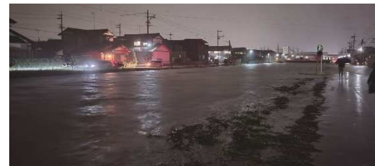
二級河川家代川の溢水状況(掛川市下垂木) ※カーブミラー付近で溢水している。
