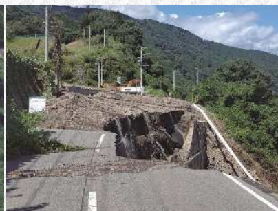
【左】【中】(国)473号(島田市福用) ※路肩決壊により道路が寸断し、通行止めとなった。被害は法面下の大井川鉄道にまで及んでいる。
