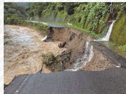
【左】【中】(国)473号(島田市福用) ※路肩決壊により道路が寸断し、通行止めとなった。被害は法面下の大井川鉄道にまで及んでいる。
