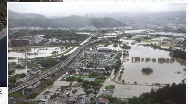
ほぼ満水状態となった麻機遊水地(静岡市葵区芝原ほか)
