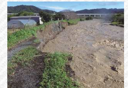
二級河川原野谷川の堤防決壊(掛川市原里)
