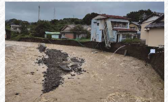
二級河川庵原川の護岸決壊(静岡市清水区庵原町) ※左岸側が大きく侵食され、家屋に迫っている。川幅は2倍以上に広がっている。
