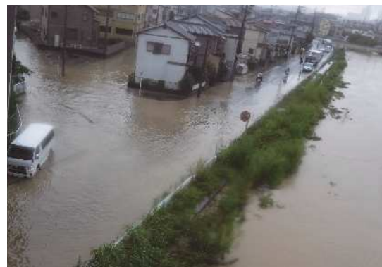
二級河川巴川と周辺の溢水状況(静岡市葵区南沼上)
