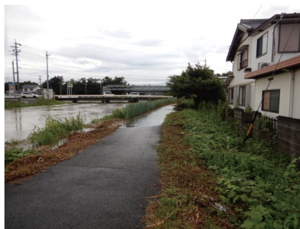
一級河川安間川(浜松市東区)
