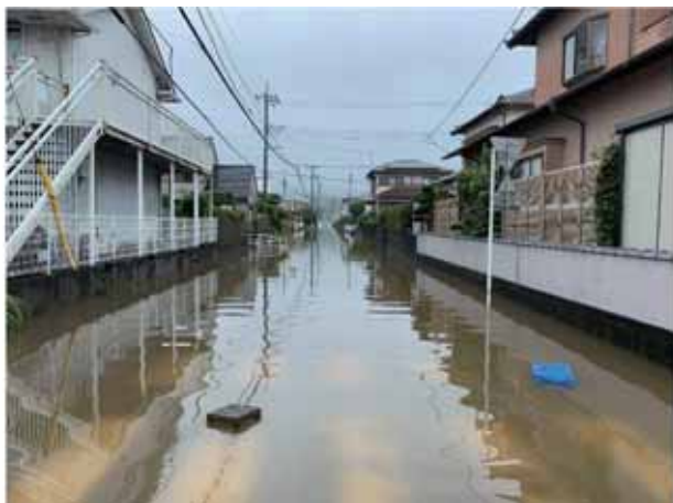
高橋川流域の浸水状況（沼津市）
