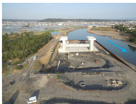
坂口谷川水門の建設状況
