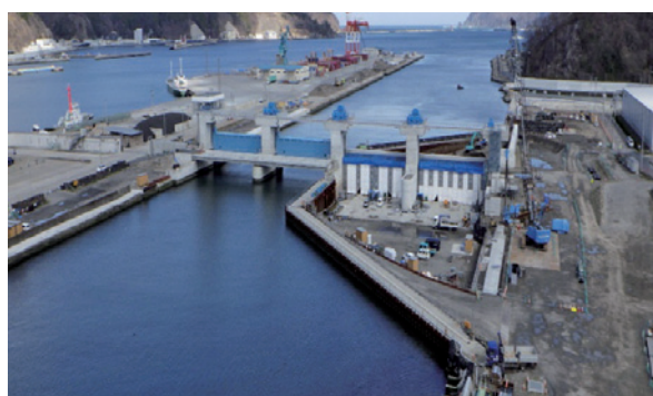
二級河川甲子川水門（水門の上屋工事を実施）
