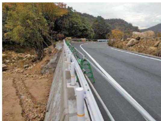
復旧後(令和2年2月)
