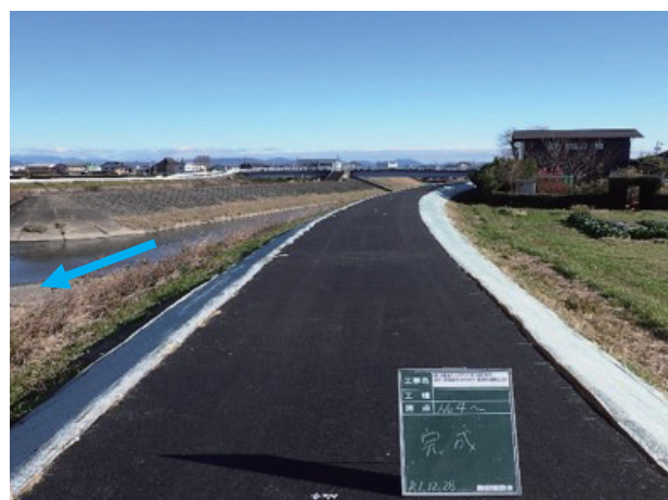
堤防天端舗装（馬込川・浜松市）
