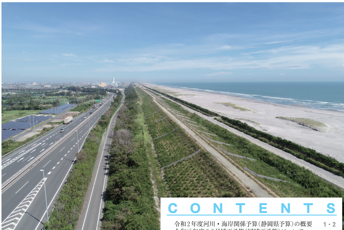
竣工した浜松市沿岸域防潮堤(浜松市)
