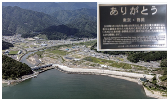
昨年完成した片岸海岸防潮堤（右上が銘板）
