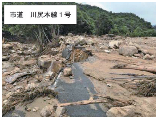
被災後(平成30年7月)
