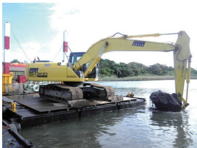
河道掘削施工状況
