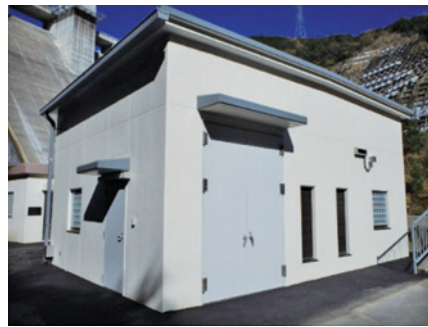
発電設備建屋
