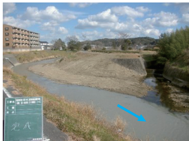
樹木伐採、土砂掘削（逆川・掛川市）
