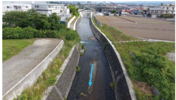
完成した新河川の状況(旧河川は右岸側)
