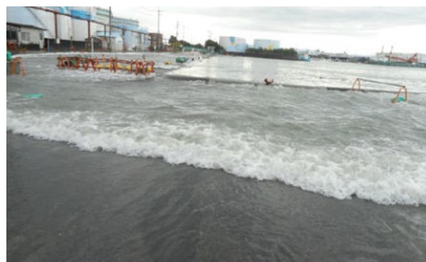
高潮による浸水状況(清水港 令和元年台風21号)
