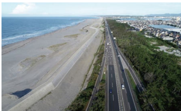
コンクリート被覆区間の防潮堤(舞阪町)
