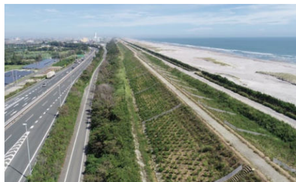
盛土被覆区間の防潮堤(篠原町)
