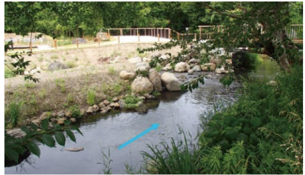
清住緑地に馴染む護岸整備
