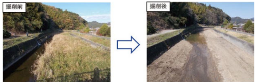
河道掘削の例
