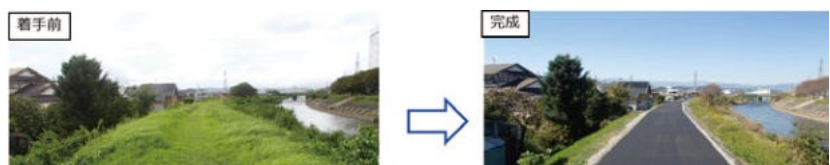
堤防天端舗装の例
