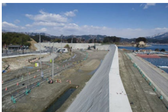
織笠漁港海岸の防潮堤工事現場
