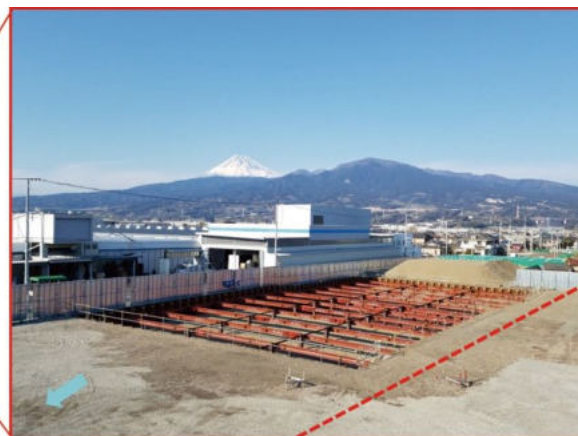
沼川新放水路の建設状況
