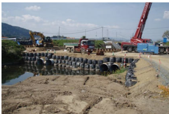
橋梁架替工事のための仮設状況
