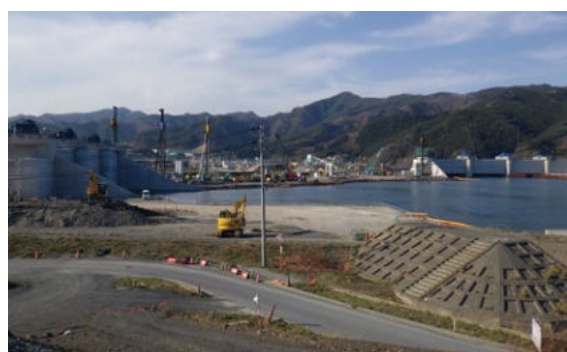
小釜川水門(左)と大槌川水門(右) 中間部分は防潮堤盛土に先立ち地盤改良中
