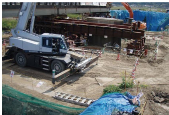
上部工の横移動 工事状況
