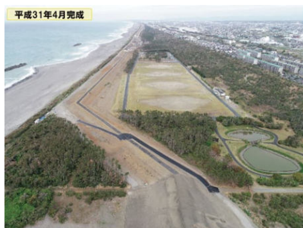
完成した浜松沿岸防潮堤
