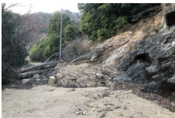
通行止めの状態が続いている市道
