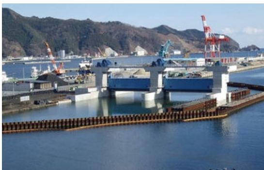
甲子川の水門工事現場
