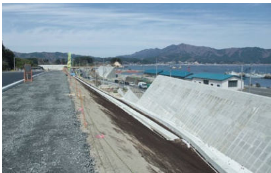
(国)45号の改築工事現場から防潮堤施工箇所を望む
