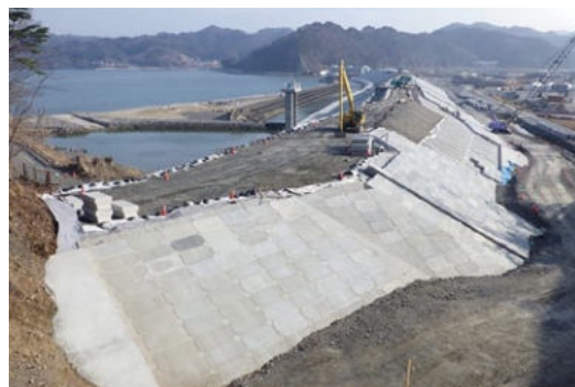
片岸海岸の防潮堤工事現場
